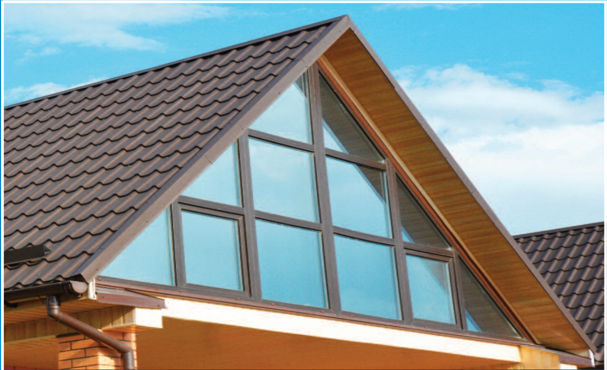
Dieser Giebel wurde mit Spiegelfolien verklebt. Dazu ist eine Arbeitsbühne/Steiger nötig.
