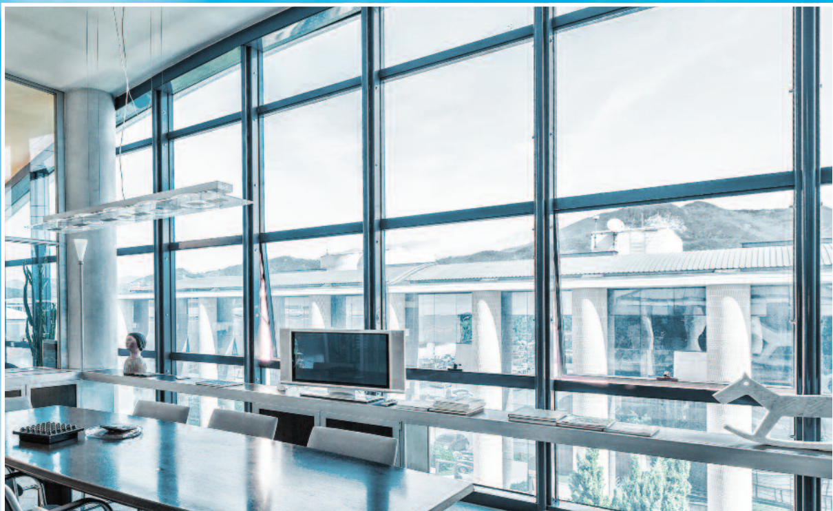
Komplettverspiegelung einer Bürofassade. Hitzestrahlung und Blendung werden um ca. 50% reduziert.
