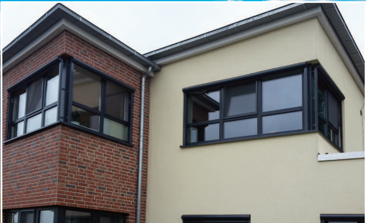
Die 3-fach-Verglasung erfordert auch hier eine Spezialfolie.
